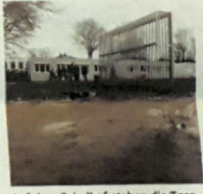
Auf dem Schulhof stehen die Tore im Matsch - hinten die Container.
